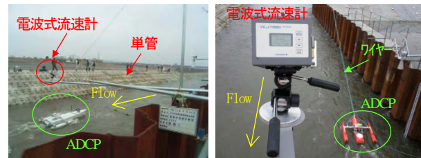
図-3 計測状況(左:下流側, 右:上流側)
