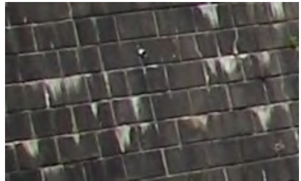
写真-3 現況護岸形状
