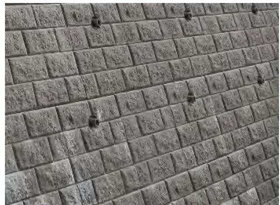
写真-4 新設護岸形状
