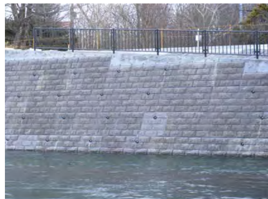
写真-5 H22年度の施工箇所
