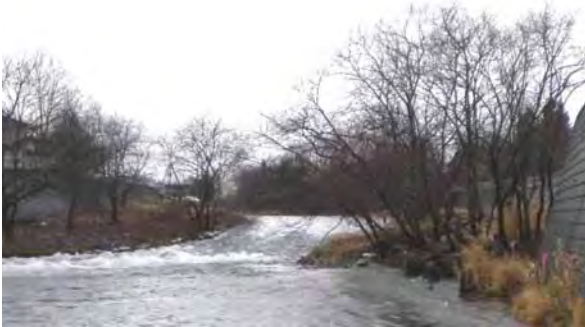
写真-6 現況落差工
