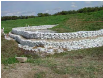
写 1-2 漏水対策 (月輪工法)
