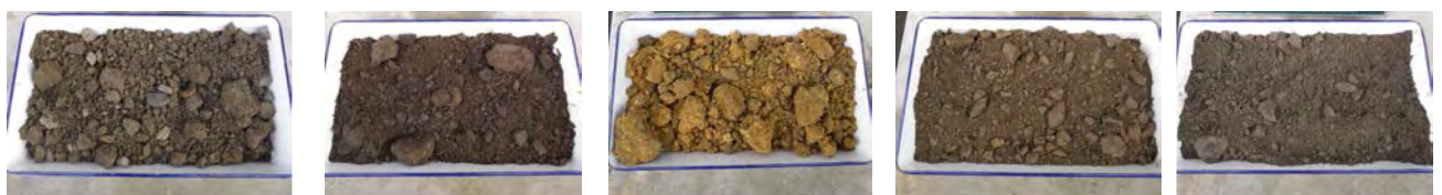
(a) 神削覆道 (b) 木巻覆道 (c) 湯泊第1覆道 (d) ルランベツ覆道 (e) 美幌覆道
