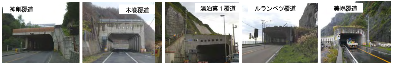
写真-2 各覆道の全景
