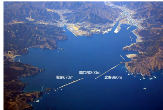
写真-1 釜石港湾口防波堤 1)
