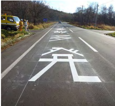
写真-4 新たな路面表示
