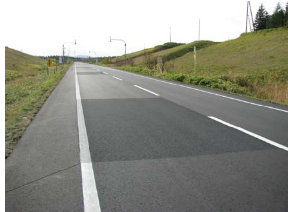
図 5 試験施工箇所の様子
