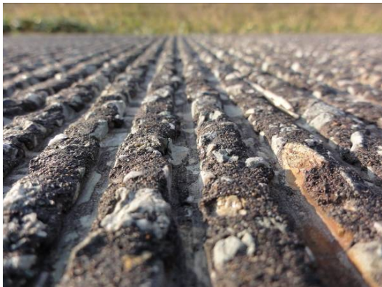
図 18 施工後1年目の溝の状態
