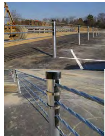
写真-13 改良防護柵設置状況
