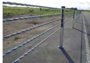
写真-15 改良防護柵(t=4.2mm)
