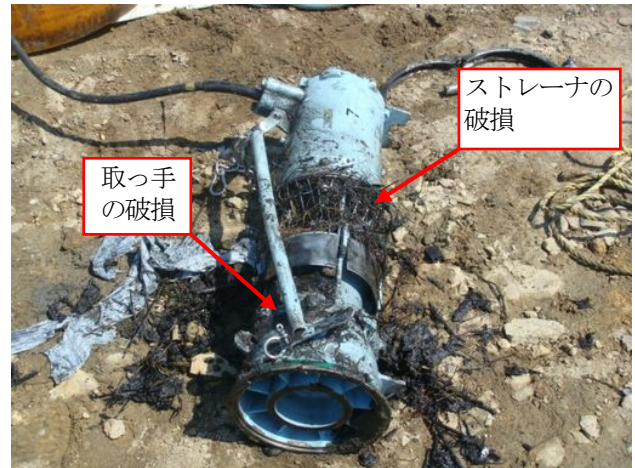
写真-6 破損したポンプ
