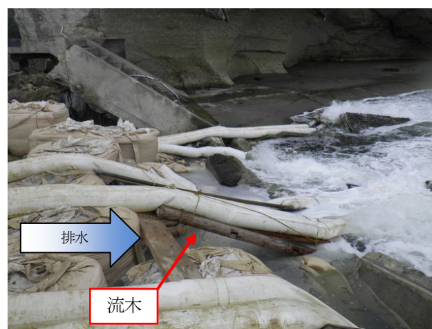
写真-4 流木を活用したホースのサポート例
