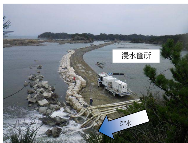
写真-3 排水状況(潜ヶ浦ブロック)
