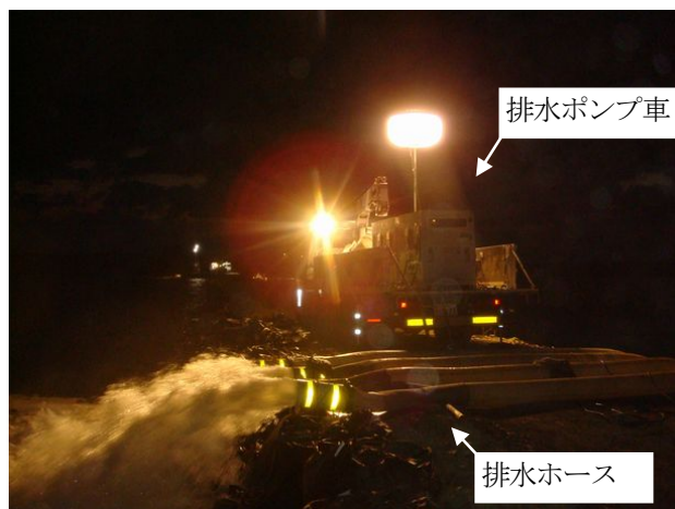
写真-9 照明装置の使用状況
