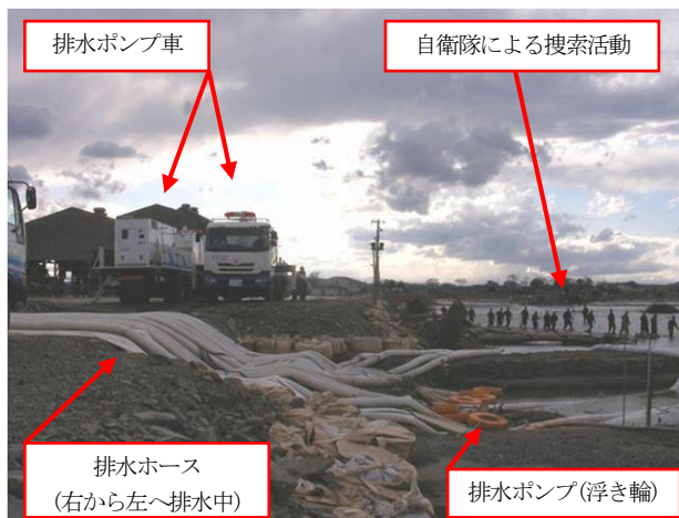
写真-1 排水作業状況
