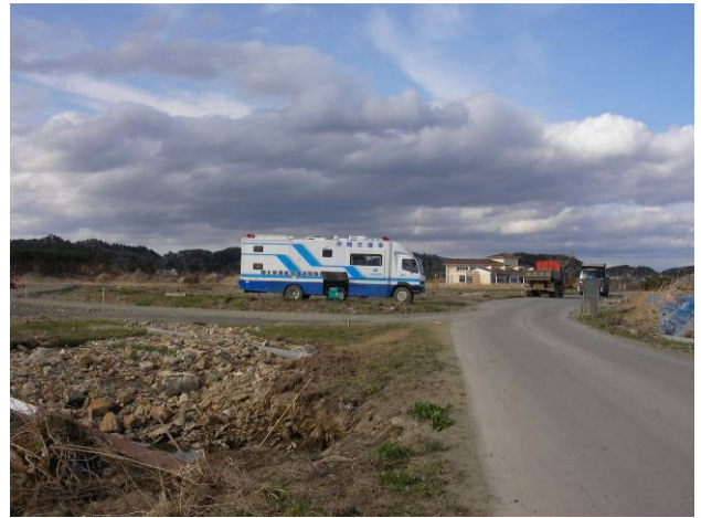
写真-10 作業現場から離れて設置された待機支援車（東松島市）
