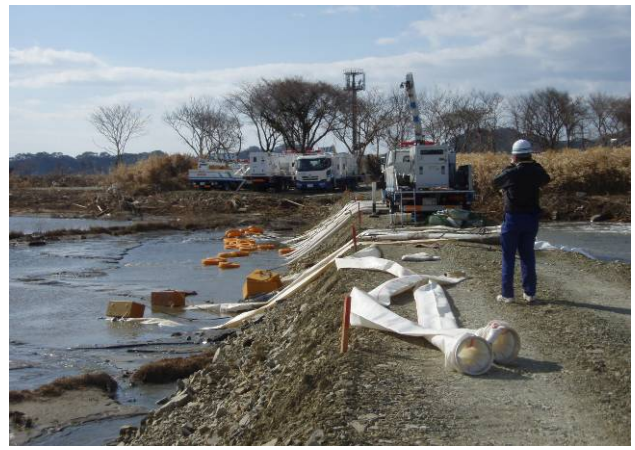
写真-9 狭い作業現場（東松島市）
