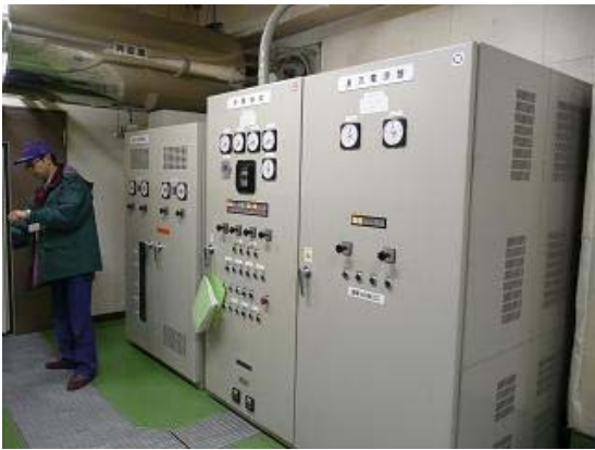
(c)米沢国道維持出張所管内設備点検支援 3月29日第2班
