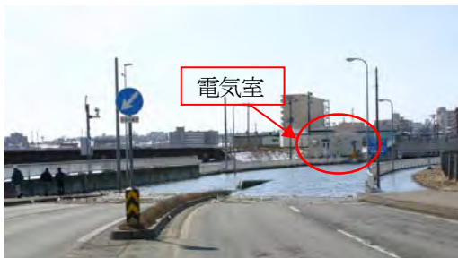
図5-2 旭アンダーパス終点側冠水状況
