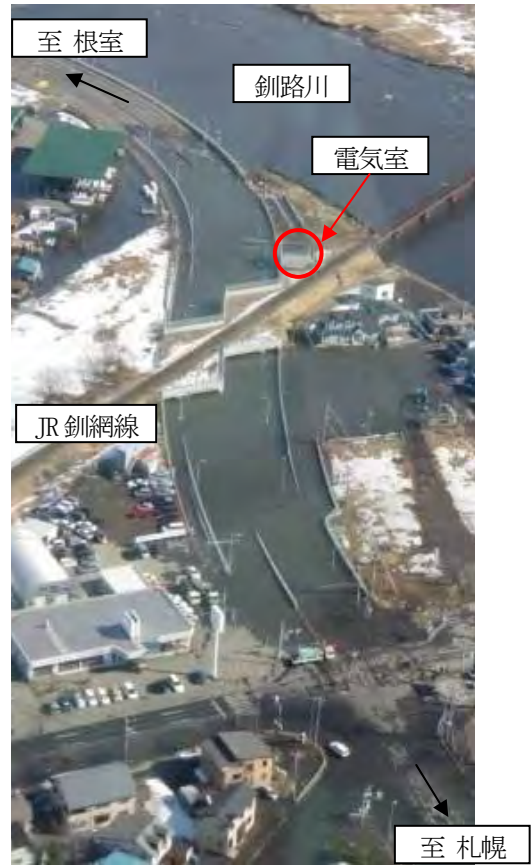
図5-3 旭アンダーパス冠水状況航空撮影写真
