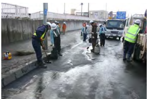
図 5-16 舗装復旧状況
