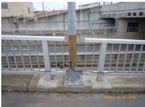
図 5-17 道路照明仮配線状況
