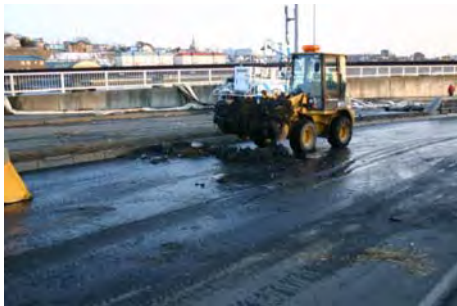
図5-7 ホイールローダによる土砂撤去状況
