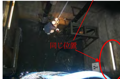
図5-11 ポンプ室排水後
