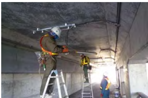
図 5-18 歩道照明交換状況
