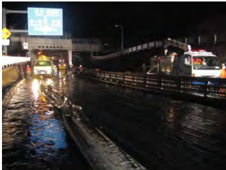
図5-6 汚泥体積状況
