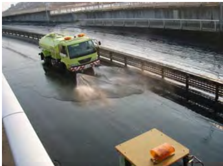
図5-8 散水車による路面清掃状況
