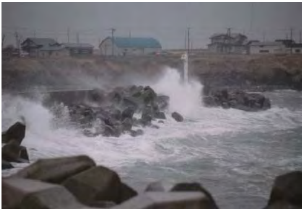
図-16 瑠瑠瑠漁港 越波時護岸状況
