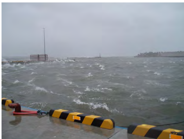
図-14 温根元漁港 港内擾乱状況
