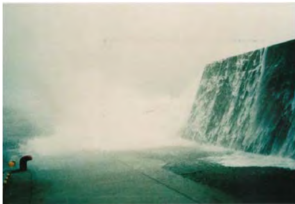
図-17 瑠瑠瑠漁港 東護岸越波状況
