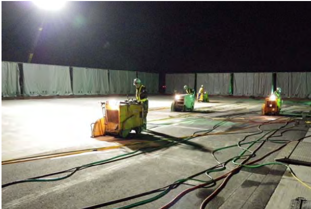
写真-7 舗装版切断状況
