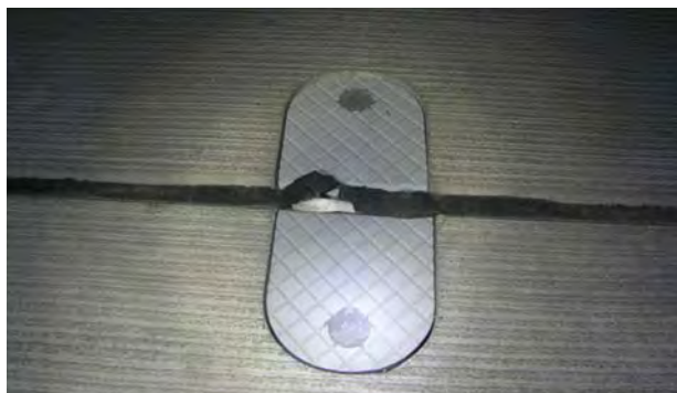
写真-14 目地材隆起状況 (RC版)
