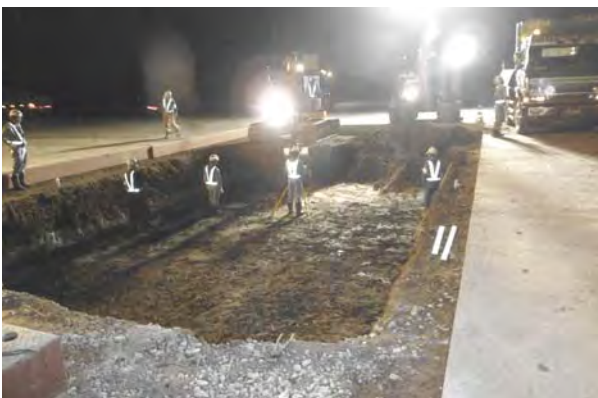
写真-9 路床掘削状況
