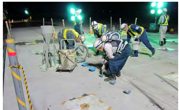
写真-11 グラウト注入状況
