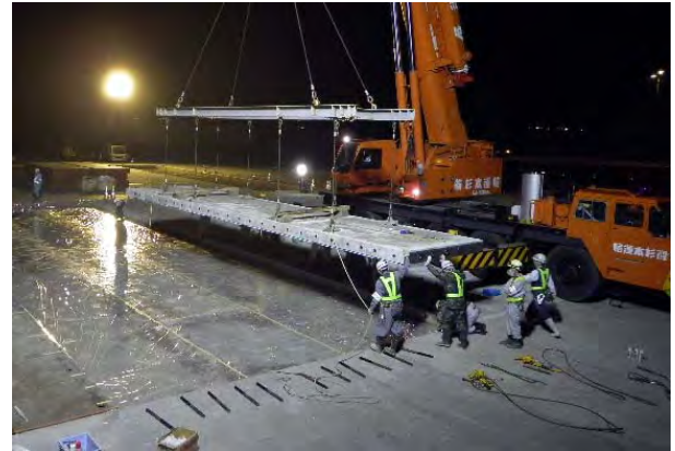
写真-10 プレキャスト版仮据付状況
