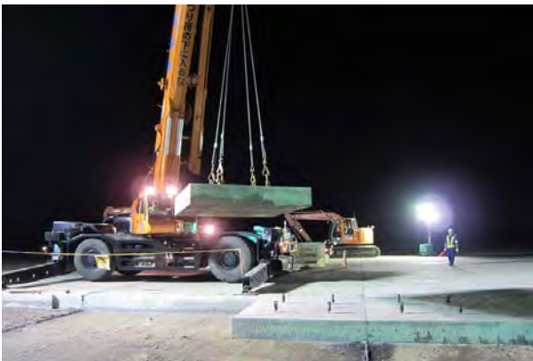
写真-8 舗装版撤去状況
