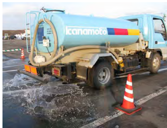
写真-3 氷膜路面作製状況
