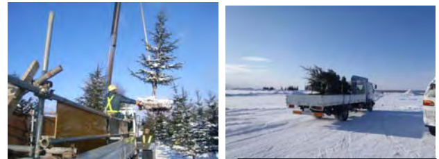
架台を設置して運搬 樹高4m以上は横積み
