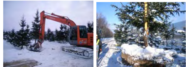
土壌凍結後バックホウにより掘り取り
