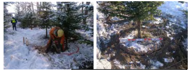
根切り終了後は残置し掘り取り作業まで自然凍結
