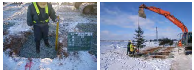
植え穴掘削(1.2×1.2m 深さ0.4m) 下部排水層: 0.1m厚砕石
