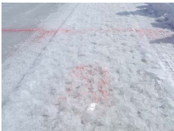
写真-8 氷板・圧雪処理装置施工後の路面（氷板路面）
