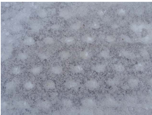
写真-9 後方排雪装置施工後の路面
