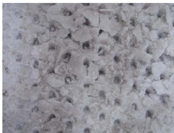
写真-10 氷板・圧雪処理装置施工後の路面（圧雪路面）
