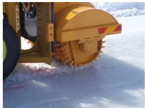
写真-6 氷板・圧雪処理装置施工状況 (氷板路面)
