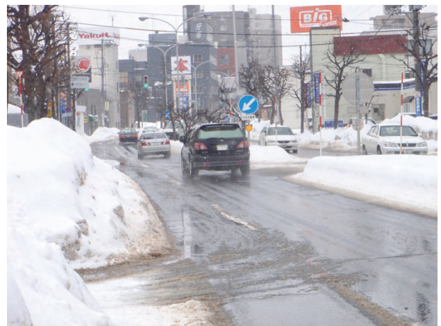
写真-1 冬期の道路有効幅員
