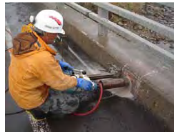
写真-3 透過法による測定を行うための試料の採取の実況
