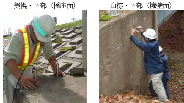
写真-2 構造物での表面走査法による測定の実況
