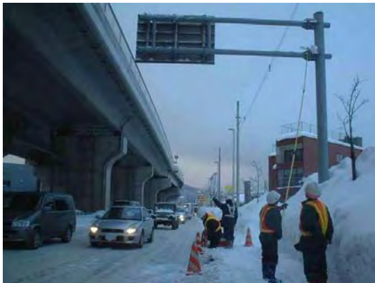
図-1 人力による雪落とし作業状況
