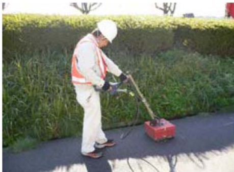
写真-3 地中レーダ測定状況
