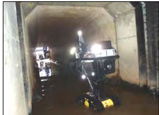
写真-8 樋門函体内 (H=1.5m) 計測状況 (遠くに見えるのが函体の外に設置したTS)
