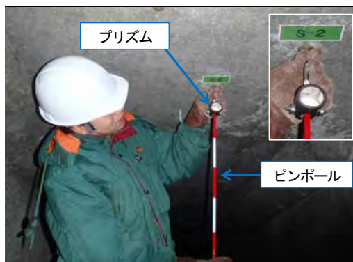
写真-6 ピンポールとプリズムを用いた計測状況
