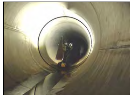
写真-9 樋管函体内 (内径1.6m) 計測状況
