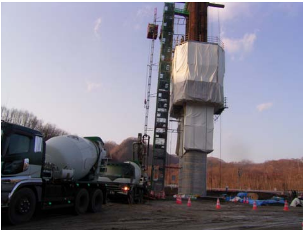
写真-1 HSF工法 防寒養生仮囲い
