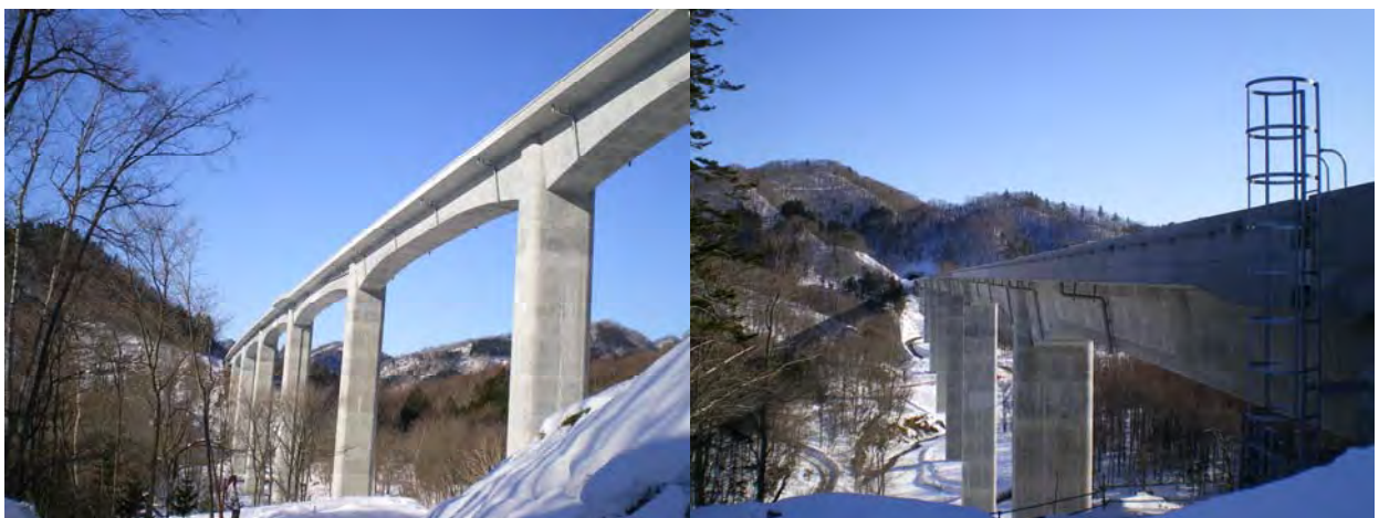
写真-1 完成写真
