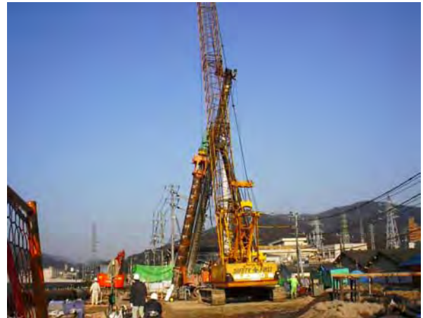
写真-1 斜杭の施工状況
