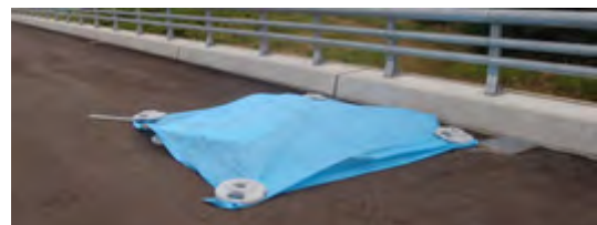
写真-10 24時間後の状況
