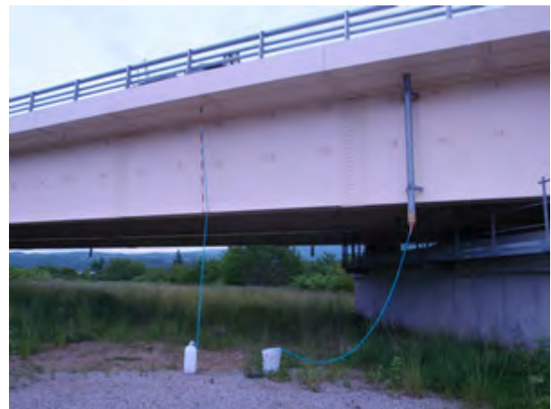
写真-8 水受け状況
