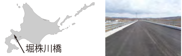
図-3 堀株川橋位置図と全体写真
