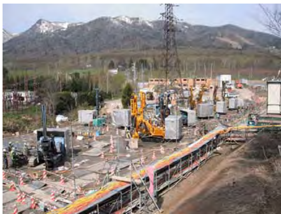
写真-5 削孔状況
