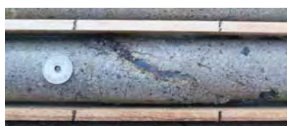
写真-3 岩盤部開口割目 ホモゲル充填状況
