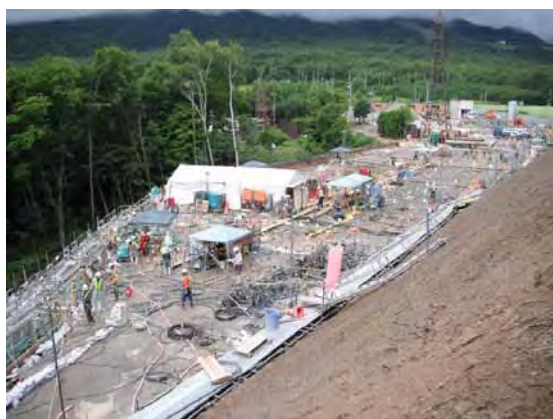
写真-6 注入状況
