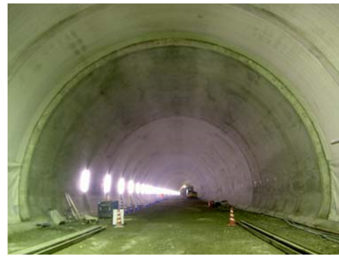
写真-6 覆工コンクリート厚さ状況
