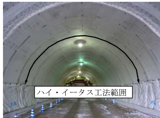
写真-4 ハイ・イータス工法布設状況
