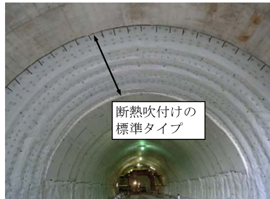
写真-3 標準的な防水シート布設状況 (断熱吹付け区間)
