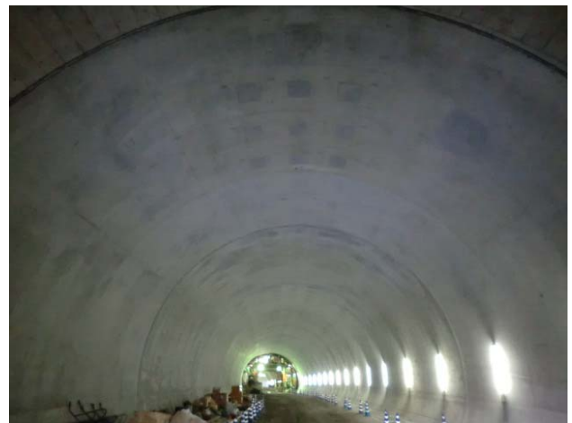
写真-7 覆工コンクリート打設完了
