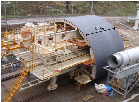
写真-1 専用鋼製型枠
