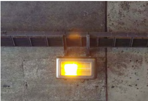
図-9 ケーブルラック方式 正面完成写真
