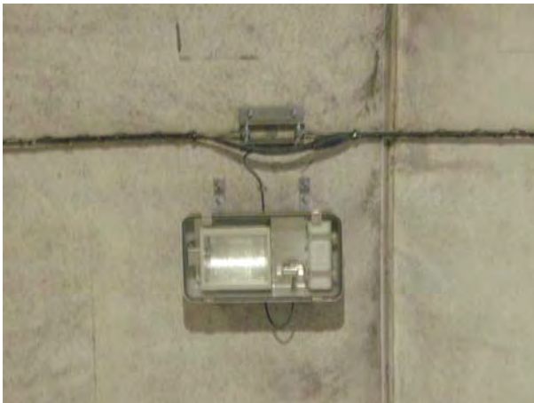
図-19 メッセンジャーワイヤー方式 正面完成写真
