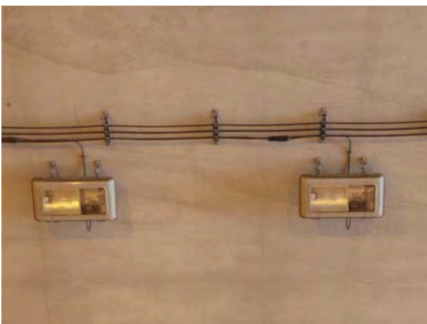
図-4 道路トンネル用ケーブル支持具方式 正面完成写真
