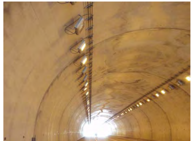
図-5 道路トンネル用ケーブル支持具方式 縦断完成写真
