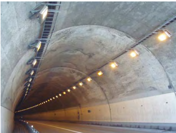
図-10 ケーブルラック方式 縦断完成写真
