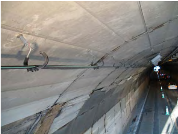
図-15 ソフトフッカー方式 縦断完成写真
