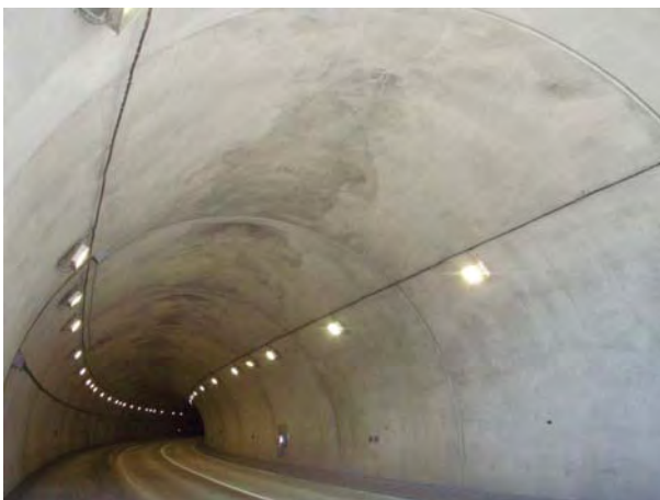
図-20 メッセンジャーワイヤー方式 縦断完成写真
