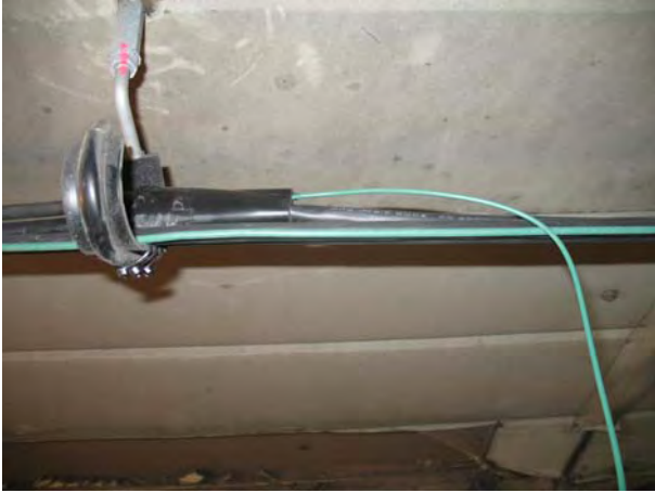
図-14 ソフトフッカー方式 正面完成写真
