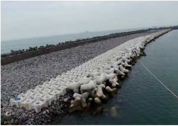
写真-2 長周期波対策工施工状況 (2011年4月撮影)
