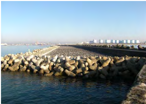
写真-3 長周期波対策工沖側端部 (2011年11月撮影)
