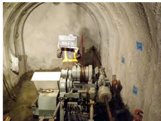
写真-1 水平ボーリング削孔状況
