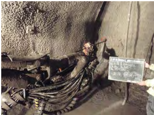
写真-2 ドリルジャンボによる穿孔
