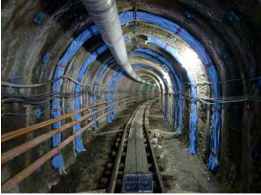
写真-5 裏面排水材設置(モノドレーン)
