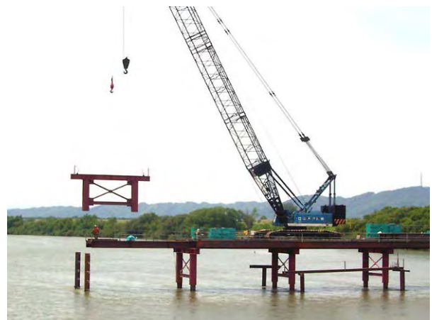
写真-1 作業構台の上部ジャケット施工状況
