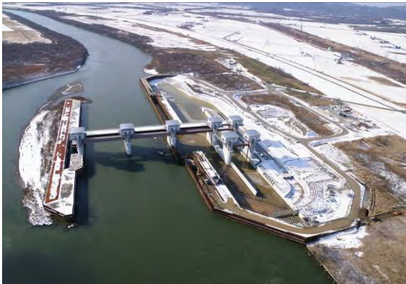
写真－7 第2期右岸部施工状況
