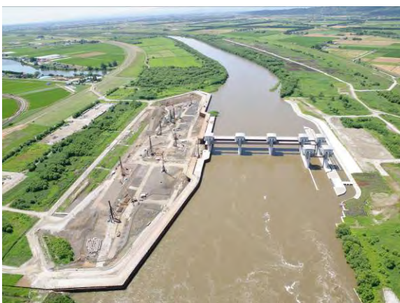
写真－8 第3期左岸部施工状況
