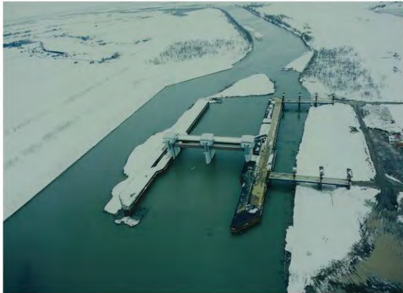
写真－6 第1期中央部完成
