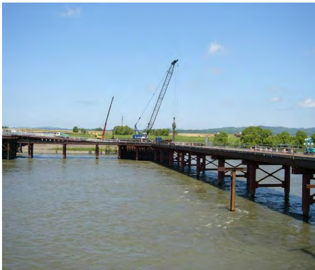
写真－2 鋼矢板施工状況
