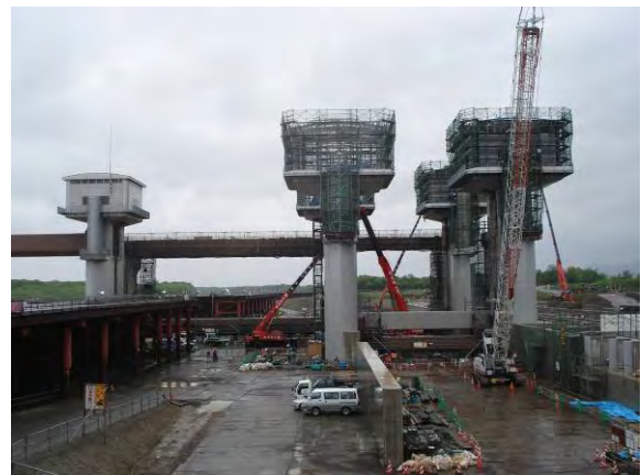
写真－4 土木・門扉外工事錯綜状況
