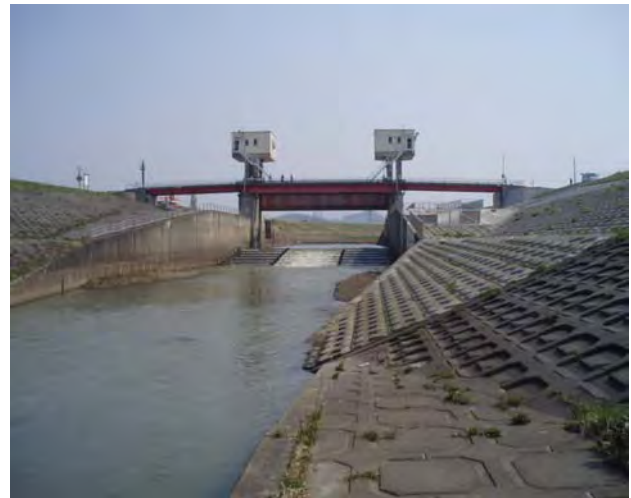
写真－1 川向頭首工全景（下流から上流を望む）
