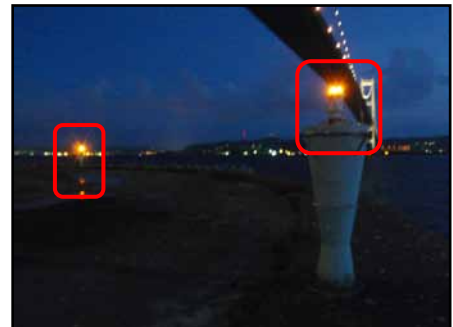
写真-11 LED式航路標識の点灯状況
