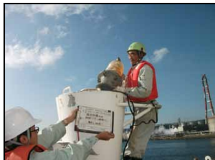
写真-10 航路標識の交換作業状況
