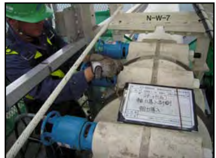
写真-5 本橋専用軸力測長機設置状況 写真-6 本橋専用機器での軸力計測状況 写真-7 ボルトテンショナー設置状況 Tetsuro Matsushima, Yoshinori Kawauchi, Satoshi Kasai.
