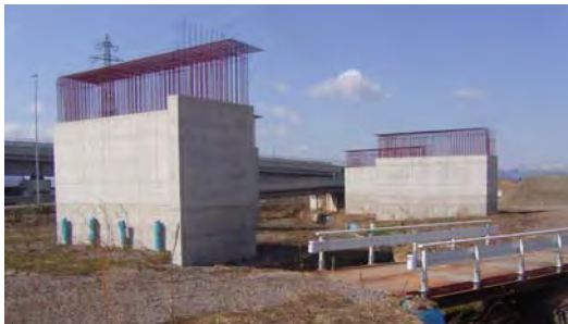
図-11 下部工の施工状況
