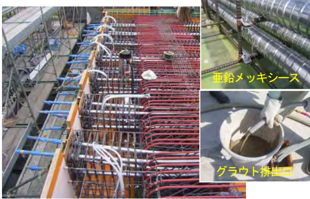
図-10 PCケーブルの配置状況
