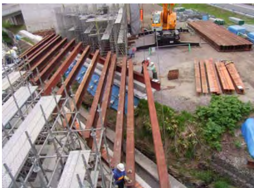
図-12 渡河部の支保工の設置状況
