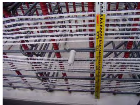
図-9 隅角部の配筋状況
