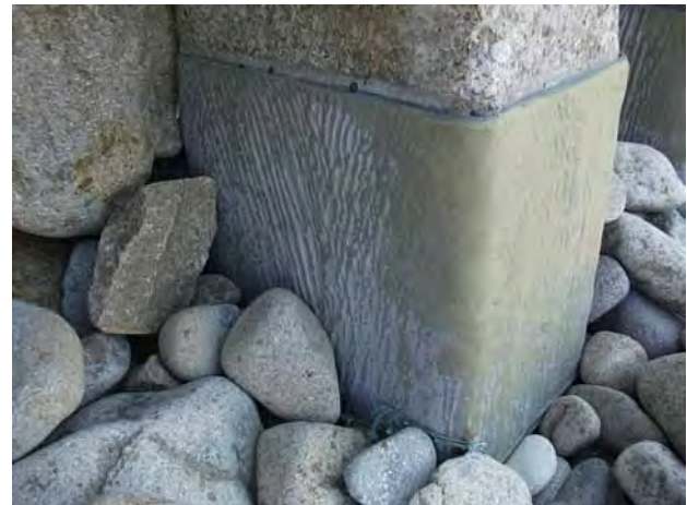
写真-3 外見上、損傷が見受けられなかったウレタン被覆材
