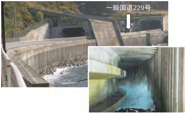
上：消波擁壁の全景、右下：消波擁壁の内側 (波の吸収によって越波の抑制が図られている)
