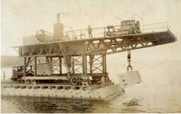
写真－2 積畳機（通称タイターン）による斜塊の据付
