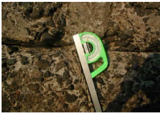
写真-11 簡易傾斜計を用いた測定状況
