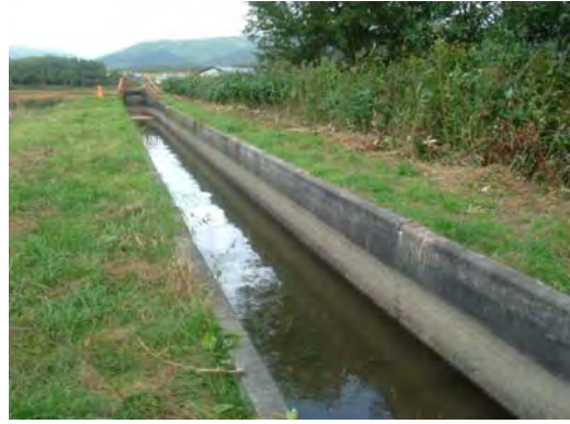
写真-1 試験施工箇所の状況（開水路）
