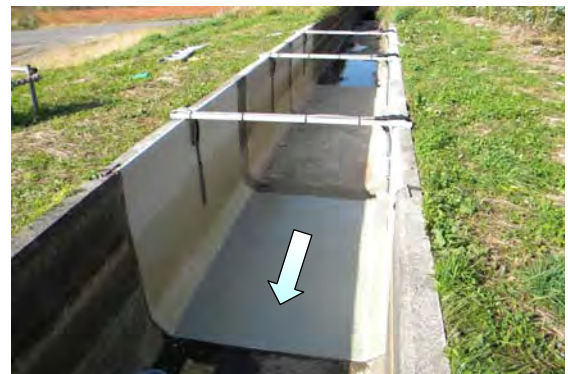
写真-3 モニタリング調査区間（開水路L=9.0m）
