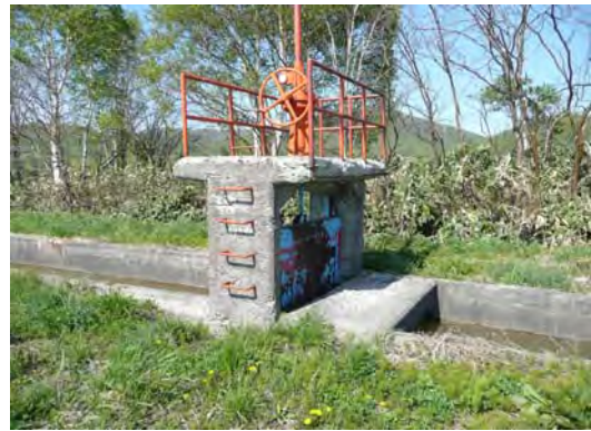
写真-2 試験施工箇所の状況（No.3分水門）
