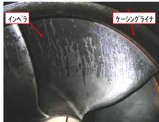
写真-3 インペラ, ケーシングの状況
