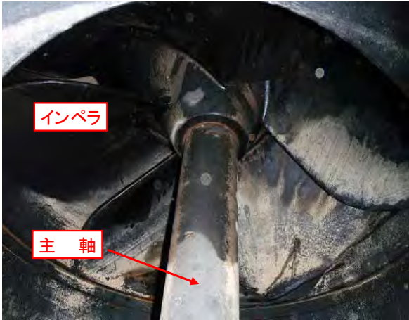
写真-5 インペラ, 主軸の状況(洗浄前)
