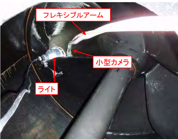
写真-6 内視鏡カメラ調査状況(洗浄後)
