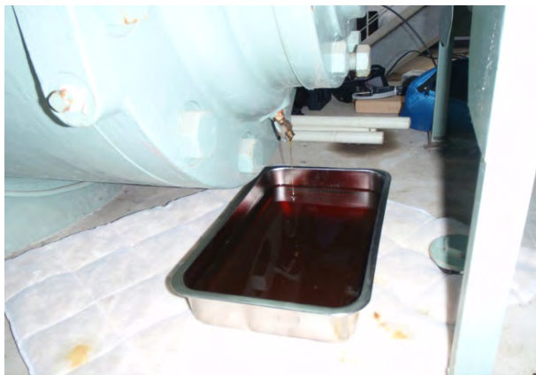
写真-8 外部軸受潤滑油採取状況
