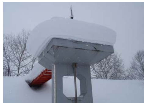
写真-1 操作台の滞雪状況の例 (12月)
