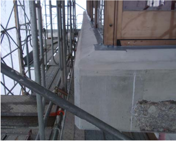
写真-11 B 樋門の試験施工後の状況
