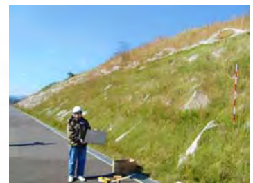
写真-2 のり面調査状況
