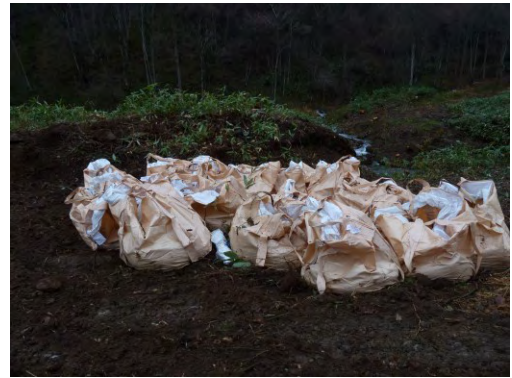
写真-9 仮植直後の大型土嚢の残置状況
