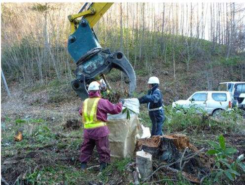
写真-7 伐り株を大型土嚢に入れる作業状況
