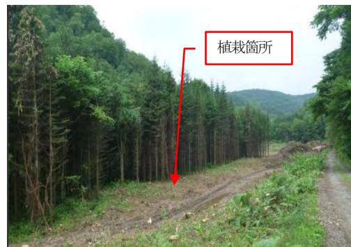
写真-2 植栽箇所の状況
