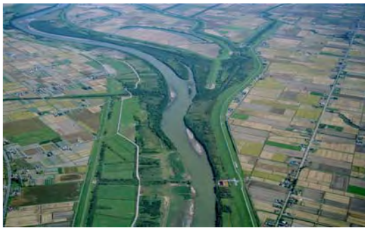
写真-2 石狩川 KP62.0～68.0 付近
