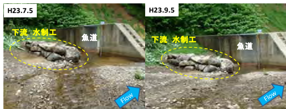
写真-3 下流水制工 直上流の土砂堆積状況
