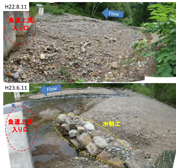
写真-1 上：H22. 7の出水により閉塞した魚道上流入り口 下：H22. 11に設置された水制工
