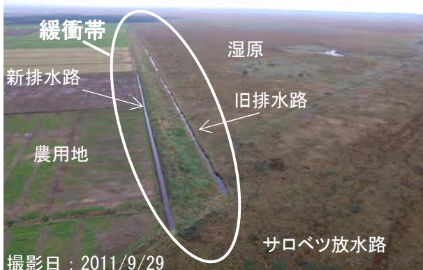
写真1 落合緩衝帯実証試験地(高位泥炭地)
