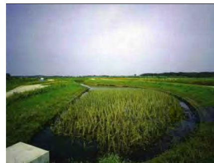
写真-5 遊水池の整備状況
