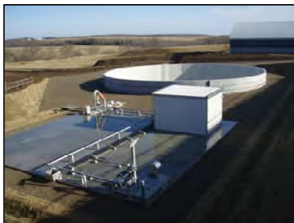
写真-1 配水調整池の整備状況
