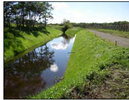
写真-3 排水調整池の整備状況
