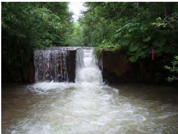
写真-2 段落型落差工
