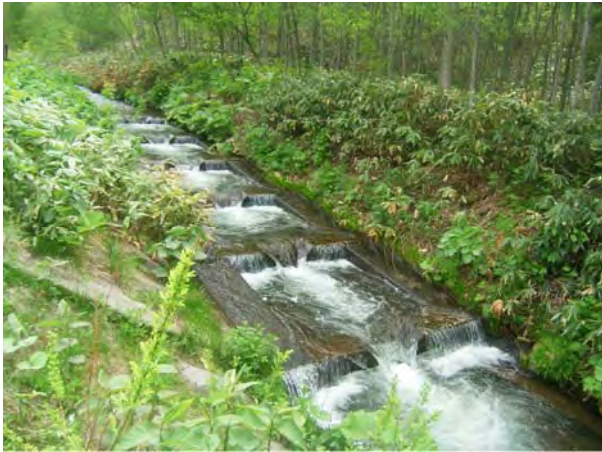
写真-1 階段型落差工
