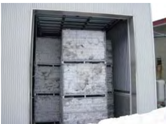
写真-5 荷捌所の雪貯蔵室状況
