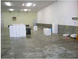
写真-2 改修後荷捌き所内
