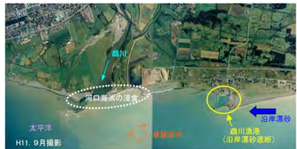
図-2 鵜川河口周辺の沿岸漂砂の状況
