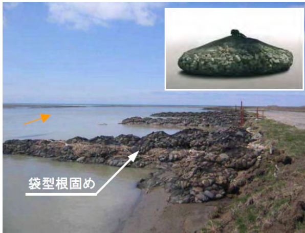
図-12 水制工の設置状況
