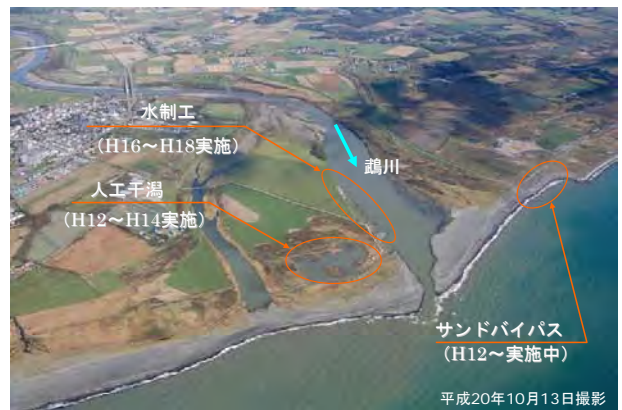
図-10 工事等の実施状況
