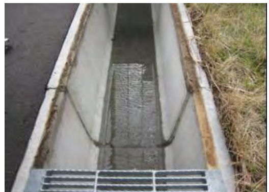
写真-5 施工1年後の状況（トラフ）
