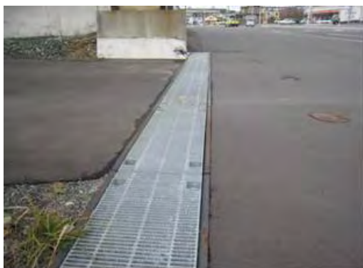
写真-6 施工1年後の状況（取付道路・活荷重あり）
