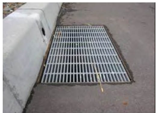
写真-7 施工1年後の状況（雨水枡）
