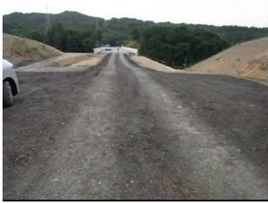
写真-8 再生骨材 100%の材料を工事用道路に使用した状況
