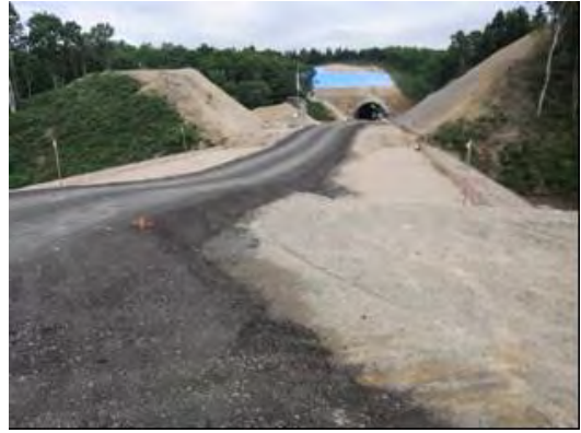
写真-9 再生骨材 100%の材料を工事用道路に使用した状況
