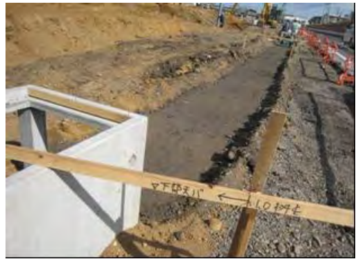
写真-3 パイプカルバートの基礎材として使用した施工状況
