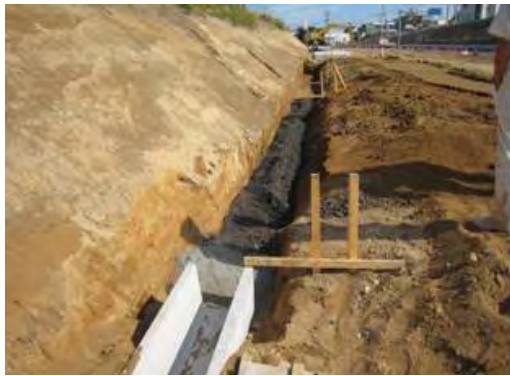
写真-2 トラフの基礎材として使用した施工状況
