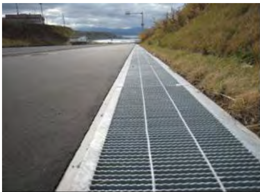
写真-4 施工1年後の状況（トラフ）
